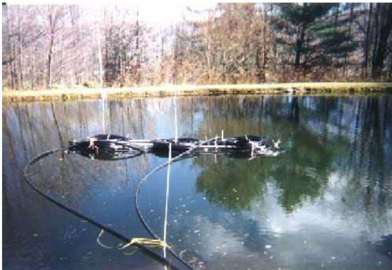
Figura B.21 – Foto dos trocadores de calor (em forma de loop) em um lago antes de seu afundamento (INT-98)
