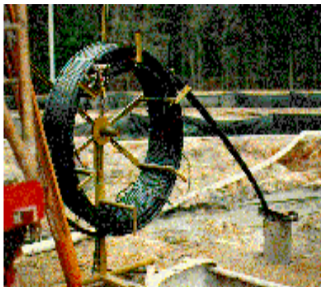
Fig. B.37 tubo sendo descido ao poço GEO-00
