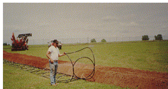
Figuras. B.15 – A partir do alto à esquerda, a primeira figura é um enrolamento de tubo de polietileno de alta densidade que será o trocador de calor a ser enterrado no solo. A seguir, medição da profundidade da trincheira -neste caso com 30 metros de comprimento, 15 centímetros de largura e 2 metros de profundidade-; desenrolar do tubo de Polietileno, posicionamento e posterior recobrimento da trincheira com a própria terra deslocada. Costuma-se também recobrir o loop com um concreto magro e depois fazer a cobertura final com terra (retirado de INT-95 ).
